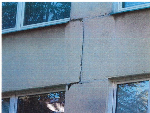
č. 41 Detail poškození spárování, pavilon č. 3, západní fasáda
