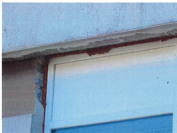
č. 49 Detail spár po výměně oken, vyplněných PUR pěnou, pavilon č. 4, severozápadní průčelí
