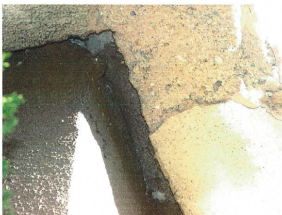
č. 38 – 40 Detaily atiky a spojení zdiva atiky a obvodového pláště, pavilon č. 4
