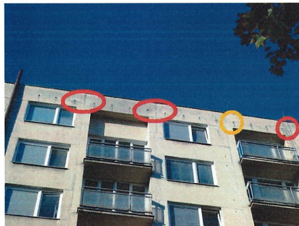
č. 20 – 21 Zákresy doporučeného umístění budek v atice východní fasády, pavilon č. 1
