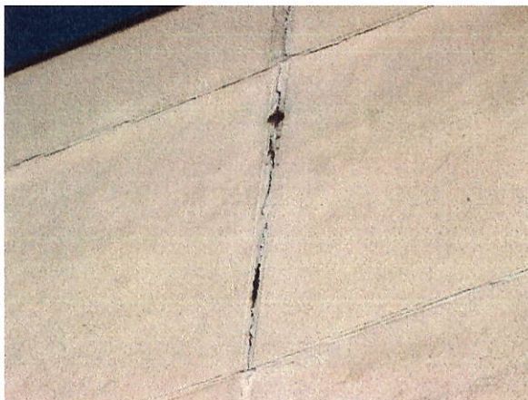
č. 37 Detail poškozeného spárování, pavilon č. 3, jižní štít
