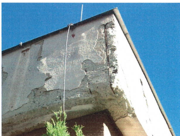
č. 38 – 40 Detaily atiky a spojení zdiva atiky a obvodového pláště, pavilon č. 4
